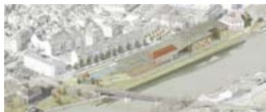
Frac Bretagne © Odile Decq - Labtop Frac Franche-Comté © Kengo Kuma & Associates
